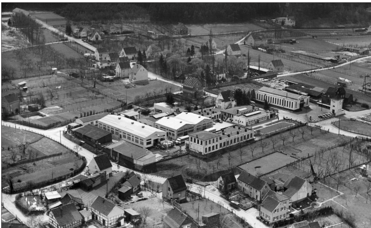
Luftaufnahme der Firma Fischer aus dem Jahr 1958 an der Hermann-Löns-Straße. Im Vordergrund verläuft die Schmiedgasse. (18)
